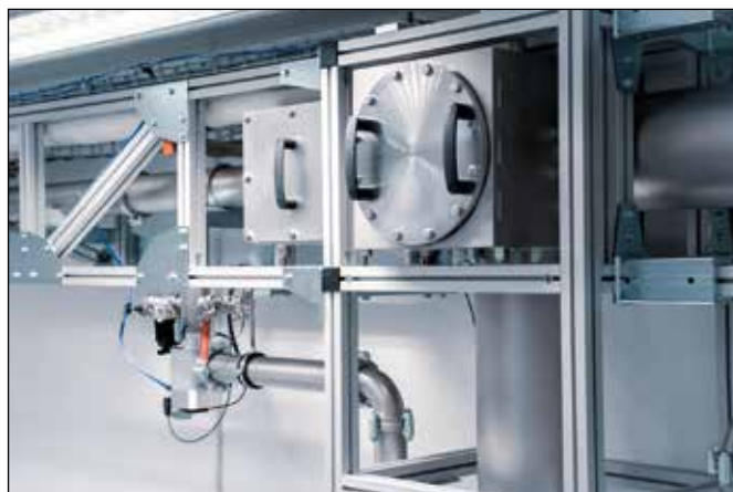
Obr. 13 Ukotvení distribučního systému do podlahy (vlevo), provedení suvného uložení (vpravo), zdroj vlastní
