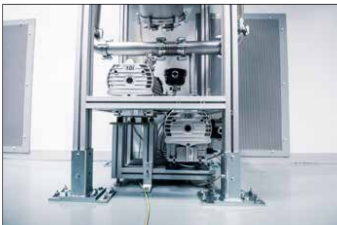
Obr. 13 Ukotvení distribučního systému do podlahy (vlevo), provedení suvného uložení (vpravo), zdroj vlastní
